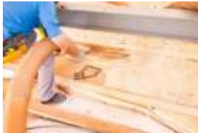
Trockensaugen eines Zwischenbodens
