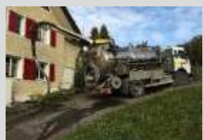
Saugarbeiten auf engstem Raum
