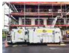
Supersauger im stationären Einsatz ohne LKW
